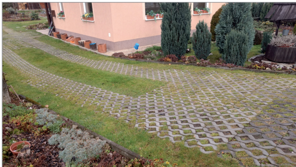
Využitie zatrávňovacej dlažby na príjazdovej ceste k rodinnému domu
