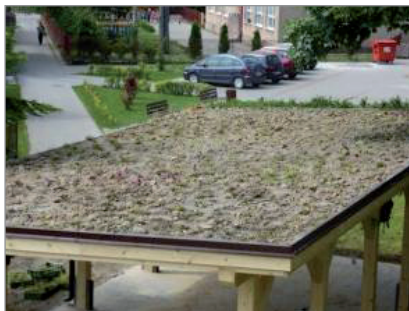
Vegetačná strecha po ukončení realizácie (Zdroj: ZŠ Rudina)
